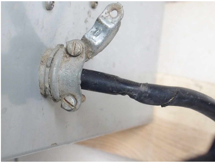
Câble d'alimentation serré à outrance et entaillé.
